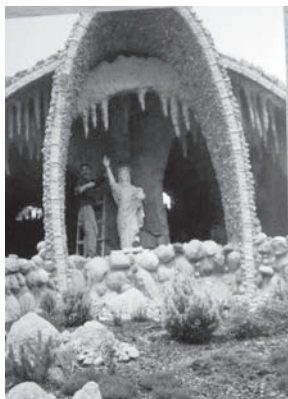
Prace po zainstalowaniu figury
